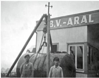
Einbau eines Benzol-Tanks, 1937
