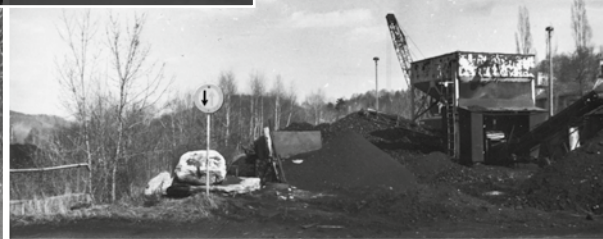
Kohleverladeanlage am Oberen Bahnhof, 1988
